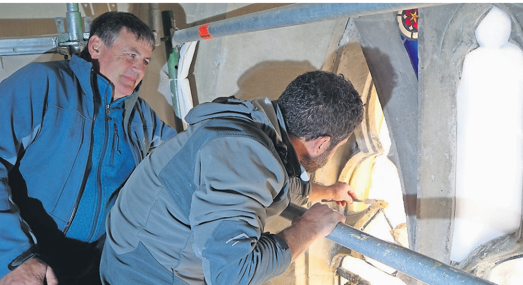
Direkt unter der Kirchendecke: Steinmetz Viktor Häberling (links) mit seinem Mitarbeiter Salvatore, der sorgfältig Sandsteinmasse an die Enden des fehlenden Stücks am Masswerk streicht.
